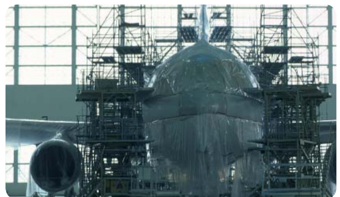
Fertig: Der ausgebaute Flieger wird säuberlich verpackt.
